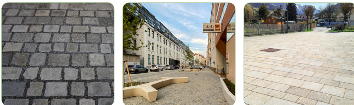
Abbildung 3: Betonstein mit aufgeweiteter Sickerfuge und kapillarbrechender Splittfüllung
