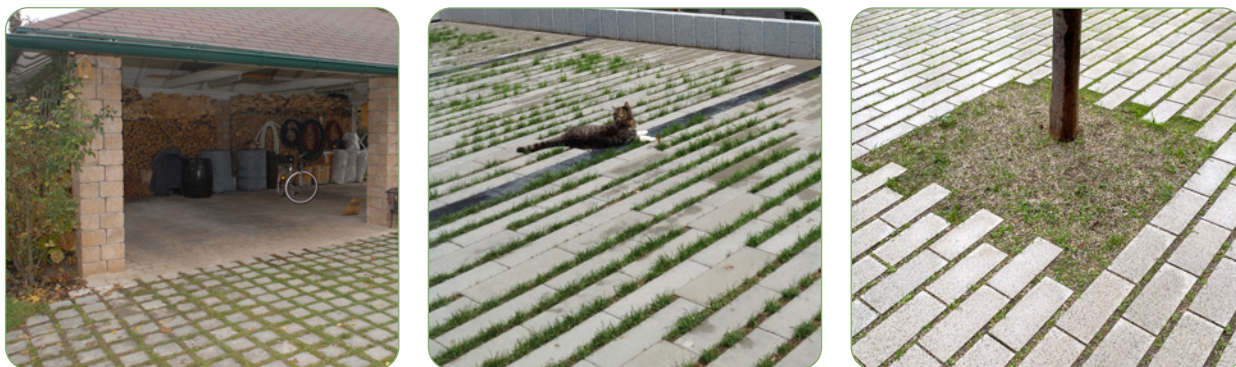
Abbildung 4: Betonstein mit aufgeweiteter Sickerfuge und kapillarer Grünfugenfüllung
