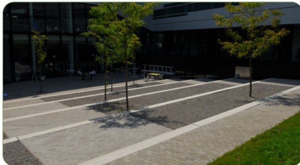
Abbildung 6: Haufwerksporige Betonstein- und Plattensysteme
